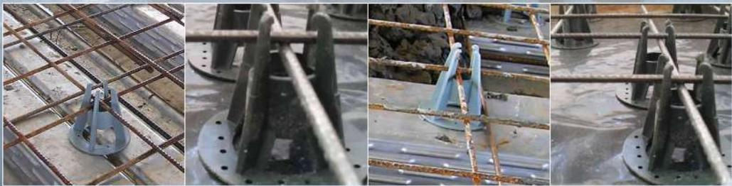
Espaciador reforzado con base circular, utilizado para pisos industriales, herrajes negativos y apoyo posicionador de cables de protadura.
