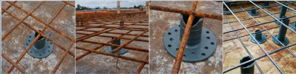
Espaciador utilizado para apoyo posicionador de cables de protadura y pisos industriales, herrajes negativos.
