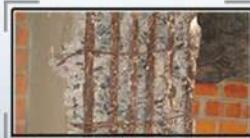
Nido de hormigón en la viga, originalmente encubierto por concreto que no penetró entre el molde y las armaduras..
